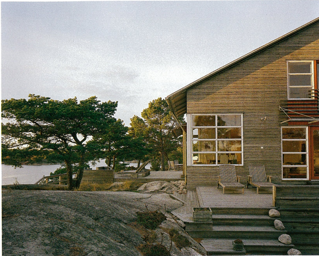
Den högt belägna huvudbyggnaden försedd med radialsågade fönsterpartier och fasadpanel behandlad med järnsulfatlösning.
